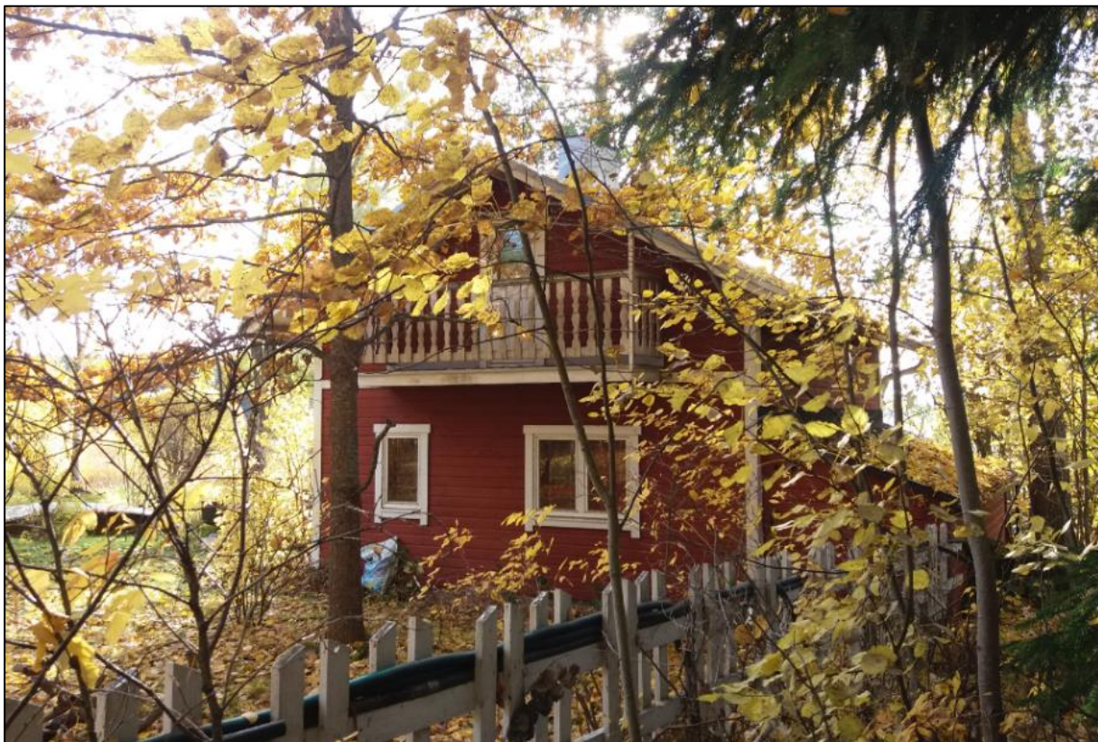
Niittyvillantie 4c:n saunarakennus syksyllä 2019
