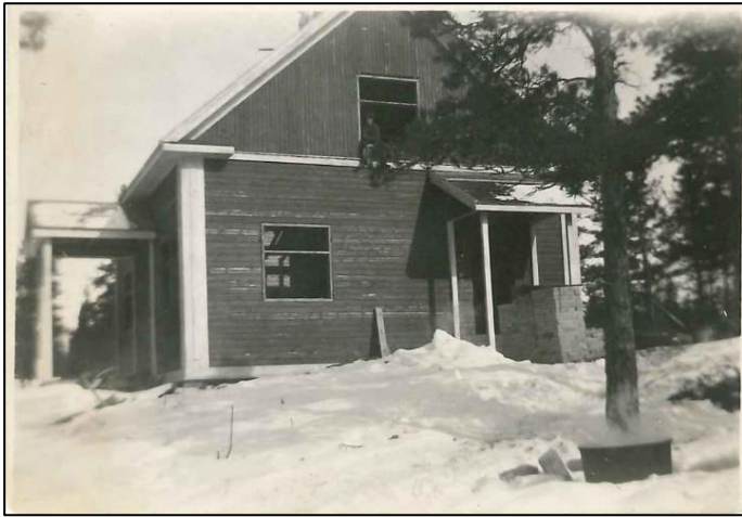
Rakentamisen aikainen kuva Niittyvillantie 4b:stä. Päädyn pyöreitä pikkuikkunoita ei ole vielä tehty.
